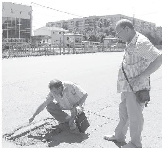
На «гарантийных» дорогах обнаружены выбоины глубиной более 5 см и шириной от 80 см
